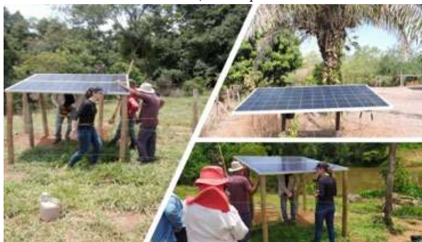
Figura 3 – Instalação de Bomba Solar no Assentamento Dom Hélder, Território Rio Vermelho, município de Itaberaí – GO.
