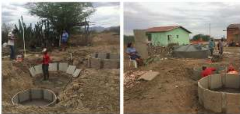
Figura 3 - Processo de construção da Bioágua Familiar Sergipe na Colônia Hebert de Sousa, em Poço Redondo - SE.
