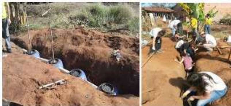
Figura 7 - Construção da fossa biodigestora
