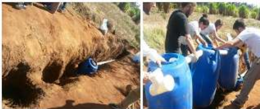
Figura 6 - Construção da fossa por bombonas
