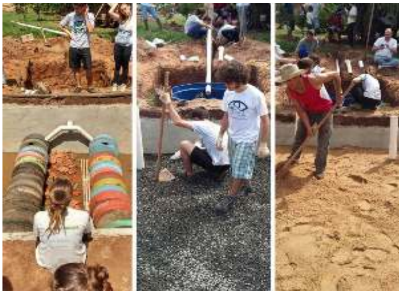
Figura 14 - Dois caminhos de pneus instalados no fundo do tanque; camada de brita; camada de areia
