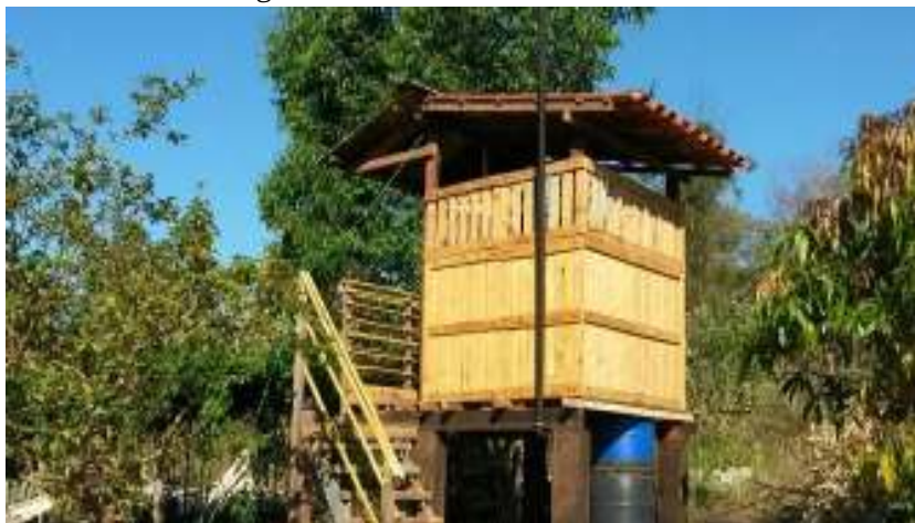
Figura 1 - Banheiro seco construído
