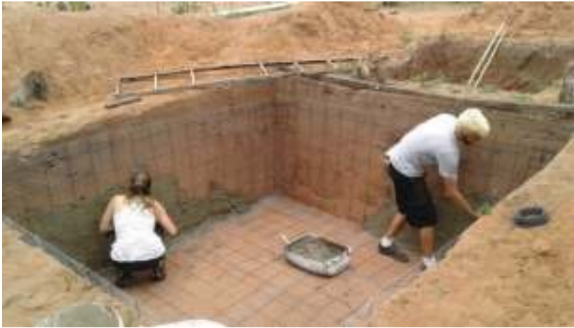
Figura 12 - Construção da estrutura de ferro-cimento
