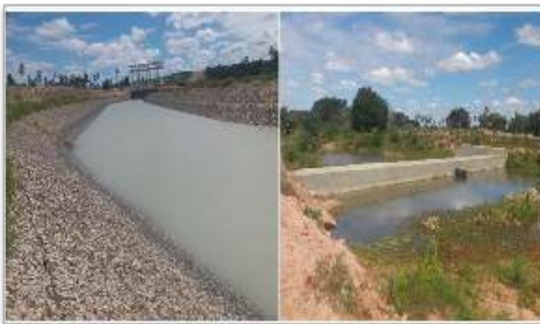
Figura 3 - À esquerda, Estação elevatória para levar água do rio Apodi para a Chapada. À direita, Barramento do Rio Apodi
