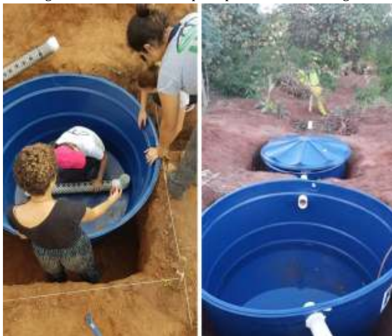
Figura 16 - Sistema de tanque séptico com filtro biológico
