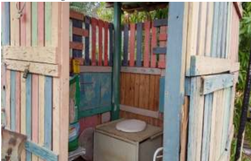
Figura 2 - Área interna do banheiro seco
