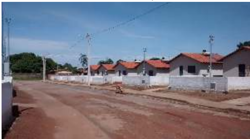
Imagem 1 - Comunidade Residencial Del Fiori: obra em finalização
