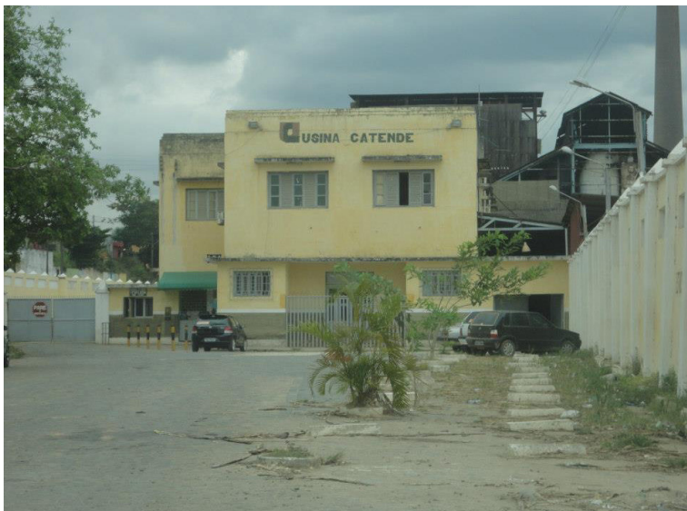
Usina Catende – Catende (PE)
