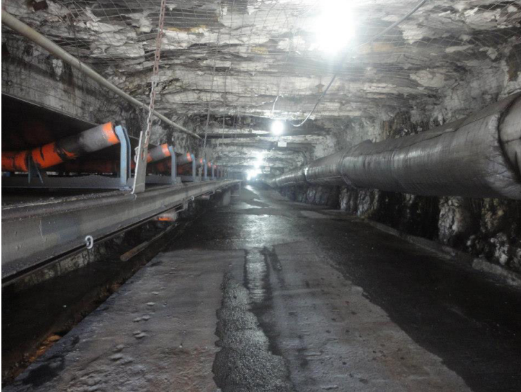
Nova mina projetada na COOPERMINAS – Criciúma (SC)
