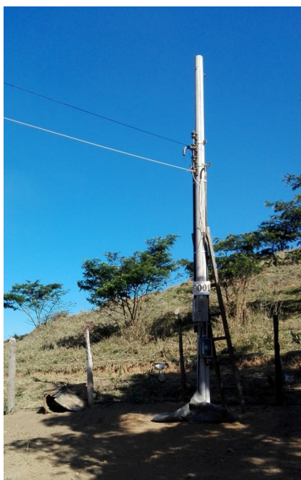
Figura 13. Foto do poste de luz construído no NB 3 segundo o padrão da Light. Fonte: próprio autor
